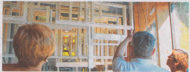
Ein Blick nach oben zu den frisch lackierten Fensterrahmen.
